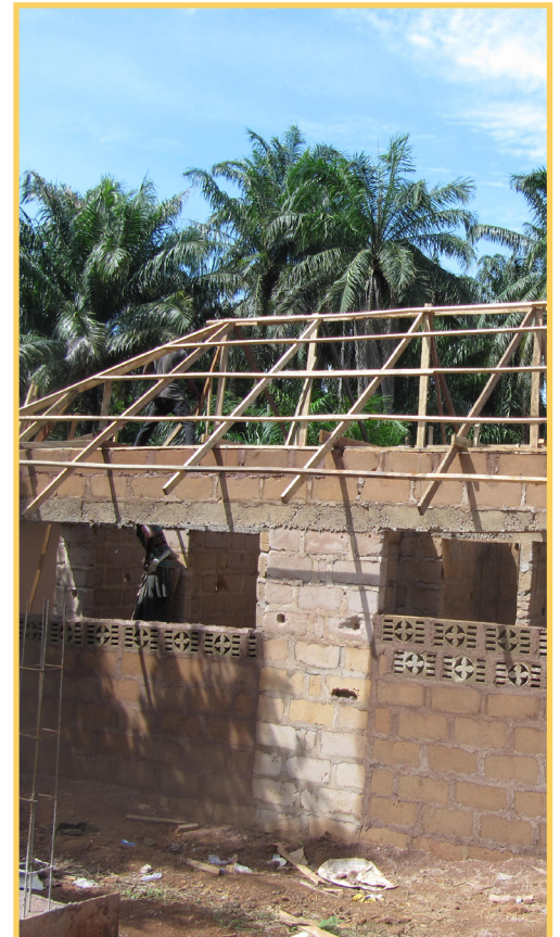
Bau einer Sanitäreanlage. Foto: IKEMBA
